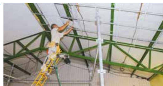
Des dalles acoustiques sur une surface importante (135 m 2 ) ont été posées pour diminuer les nuisances sonores.
