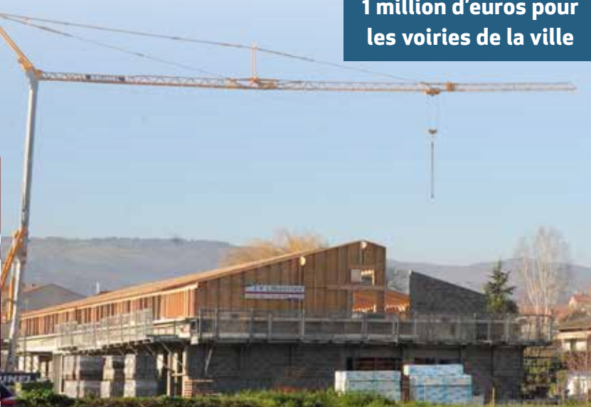
Chantier de l'école Brillié
