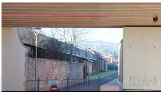
Entrée de l'Espace des associations à Moingt
