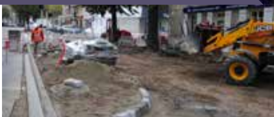
Pose des bordures de trottoir.
