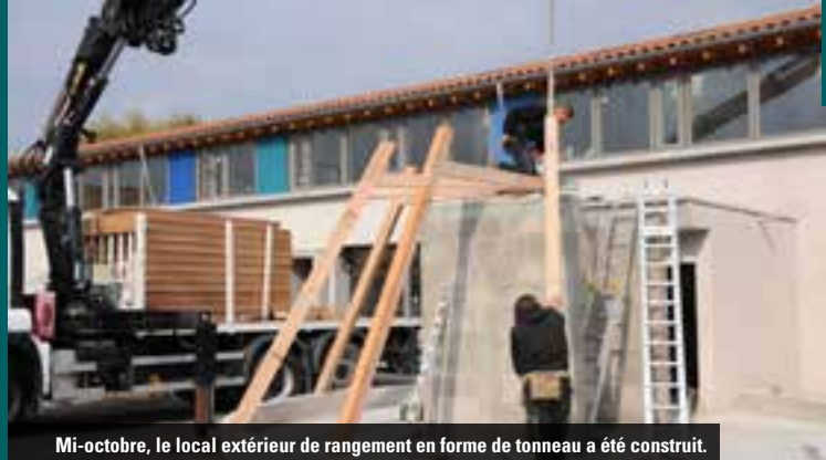
Mi-octobre, le local extérieur de rangement en forme de tonneau a été construit.
