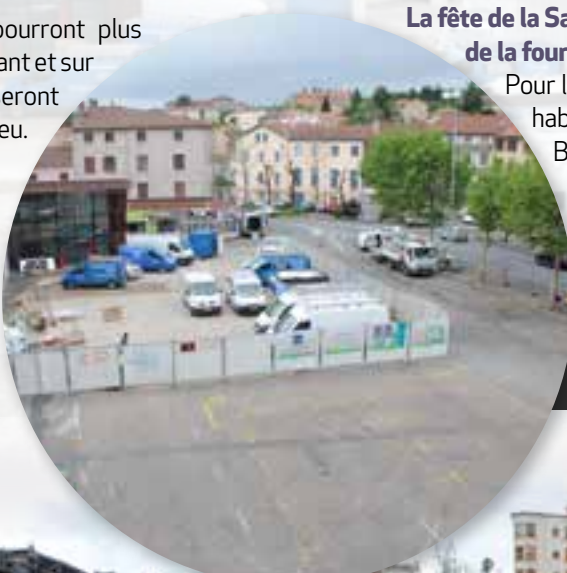
Vue de la place Eugène Baune la veille du démarrage des travaux.
