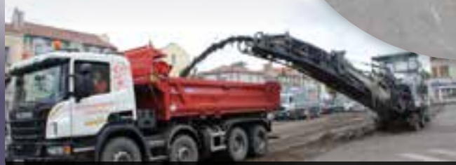
Premiers travaux de terrassement qui ont consisté à enlever l'ancien bitume avec une « carotteuse dameuse » spectaculaire !
