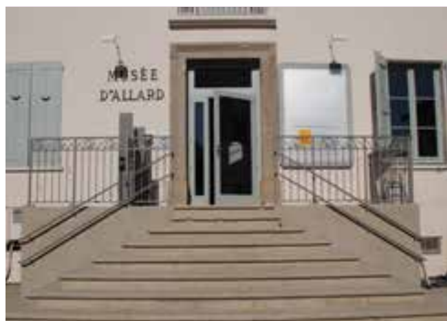
Le nouveau perron, plus large, invite à pousser la porte du musée devenu aisément accessible grâce également à une plate-forme élévatrice extérieure.
