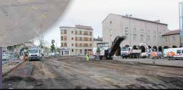
Premiers travaux de terrassement qui ont consisté à enlever l'ancien bitume avec une « carotteuse dameuse » spectaculaire !
