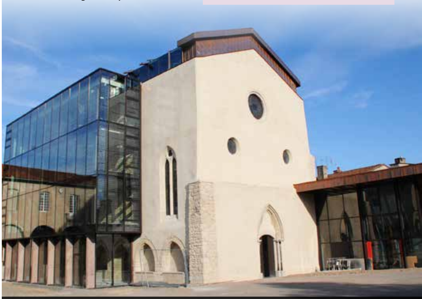
A l'issue des travaux, la façade monumentale de l'ancienne église des Cordeliers aura retrouvé toute sa splendeur grâce à un vrai travail de restauration.
