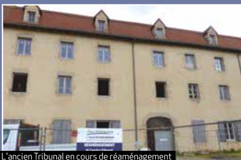
L'ancien Tribunal en cours de réaménagement
