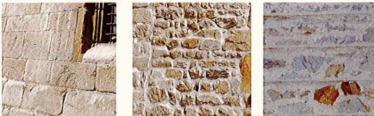
1- Façade en pierre de taille à ne pas enduire ; 2- Façade en moellons à enduire, 3- Façade à enduire à pierre vue (fin 19<sup>e</sup>)
