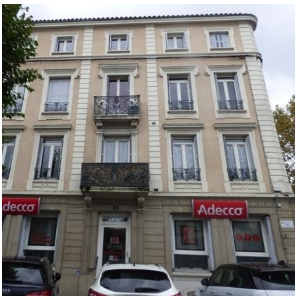
Exemples de façades en ciment moulé à Montbrison, et détail des motifs
