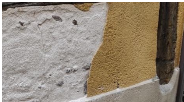
Exemples d'enduits monocouche non adhérents au support ancien ; dans le cas 2, les remontées capillaires ont provoqué la pulvérisation du support et le décollage de l'enduit
