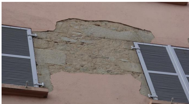
Exemples d'enduits monocouche non adhérents au support ancien ; dans le cas 2, les remontées capillaires ont provoqué la pulvérisation du support et le décollage de l'enduit
