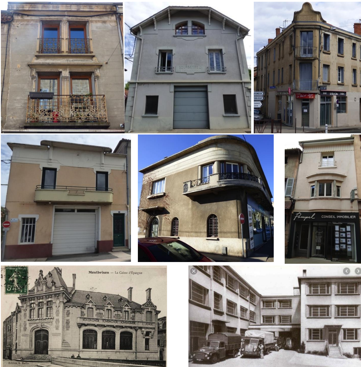
Exemples de façades Art Nouveau et Art Déco (dont certaines très dénaturées), en dernière ligne, images d'archives de la Caisse d'épargne et de l'usine Gégé, sources : Inventaire.
