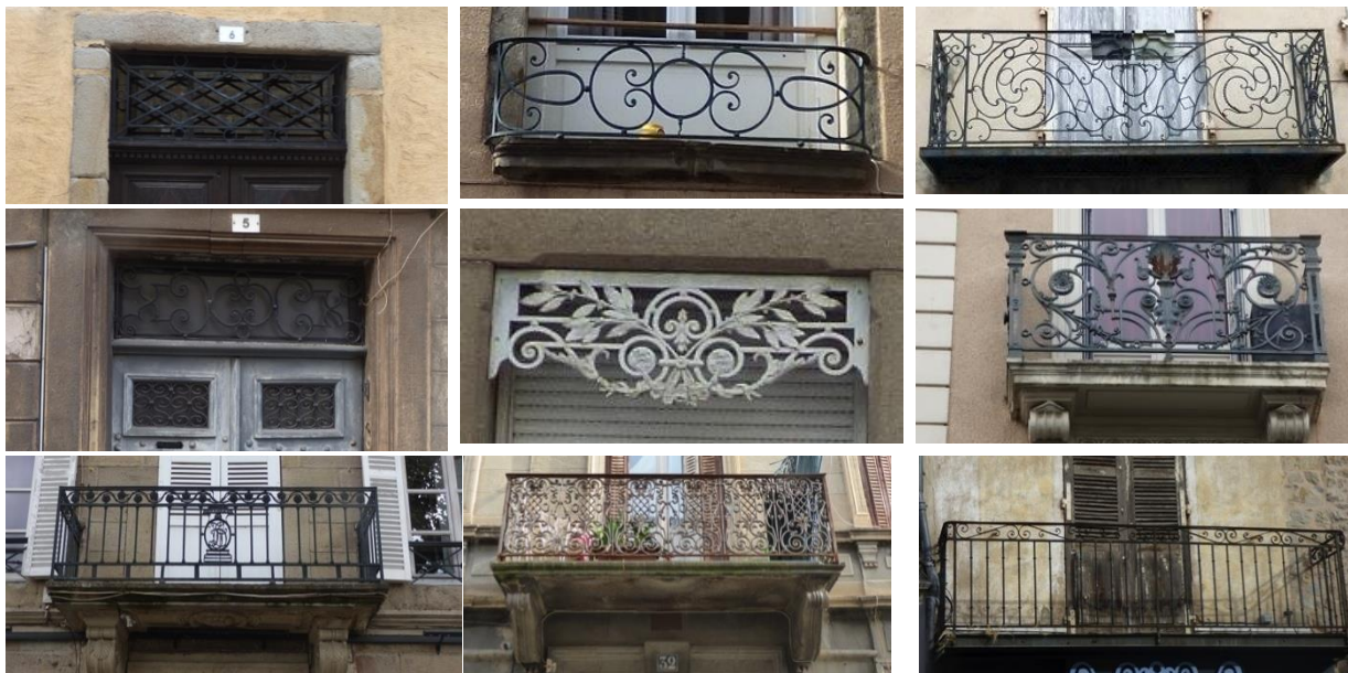
Exemples d'ouvrages caractéristiques en serrurerie, ou en bois : Garde-corps, grille d'imposte, lambrequins, grilles de portes.
