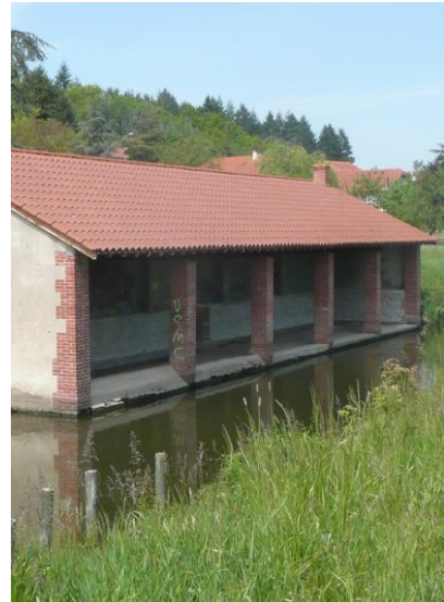
Lavoir en brique construit à même les rives Photo Archipat
