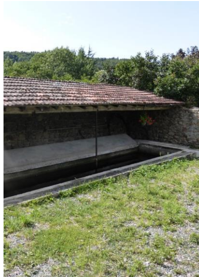
Lavoir couvert Photo Archipat
