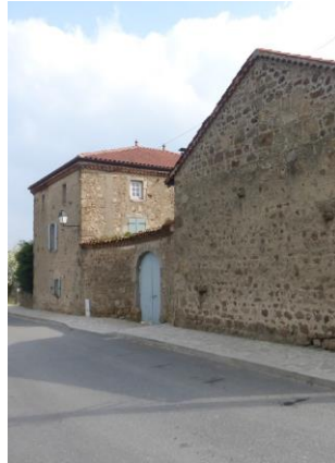
Ferme en U avec cour fermée Photo : Archipat
