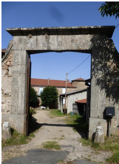
Portail en bois, encadrement en pierre de taille Photo : Archipat
