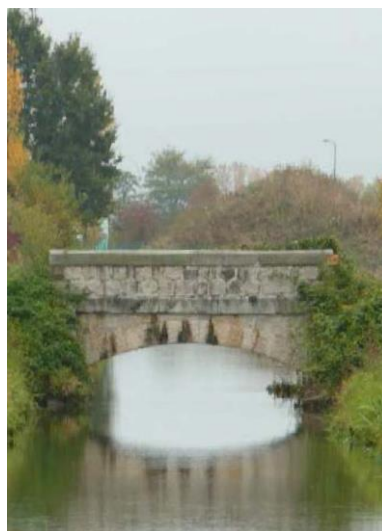
Pont en pierre XIXe siècle Photo Archipat
