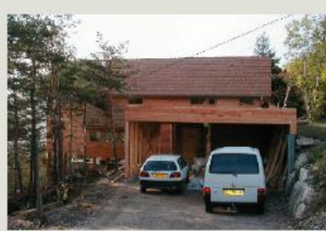
accès latéral, par le haut, parallèlement aux courbes de niveau en peut remarquer la réalisation dusoutènement des talus créés
