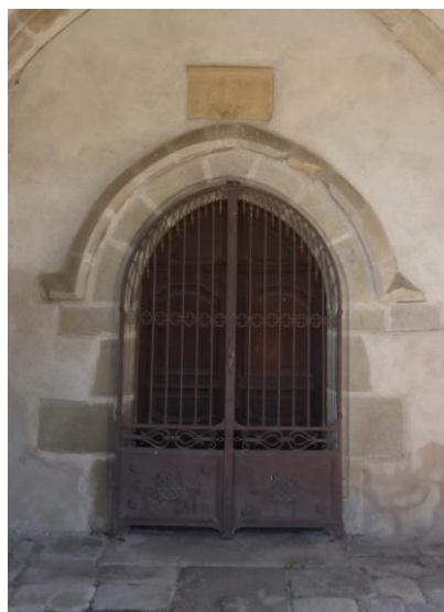
Arc brisé en pierre de taille Photo Archipat
