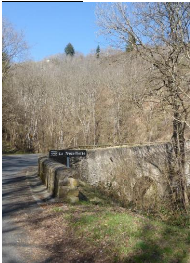
Pont en pierre à trois arches Photo Archipat
