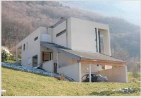
accès, stationnement et garage en partie basse
