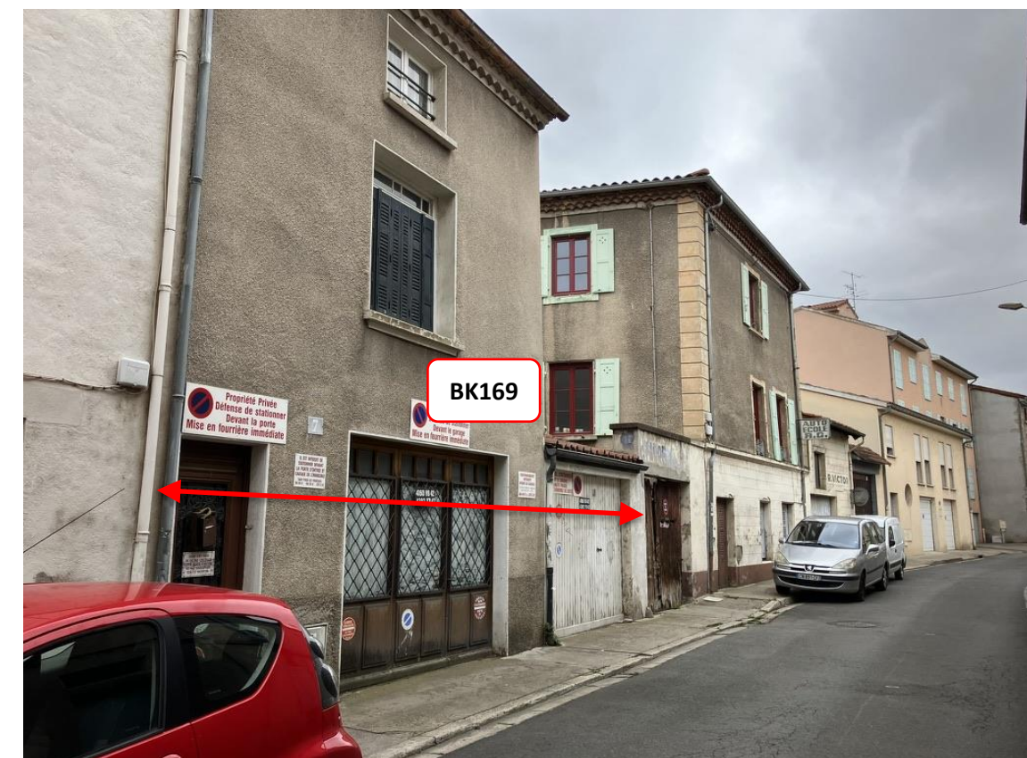
Figure 28 : Vue sur la façade sur rue des Pénitents de l'immeuble de la parcelle n°BK169
