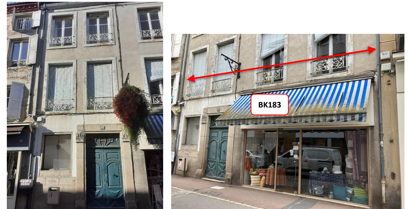
Figure 20 : Vues sur la façade sur rue Saint Jean de l'immeuble de la parcelle n°BK183
