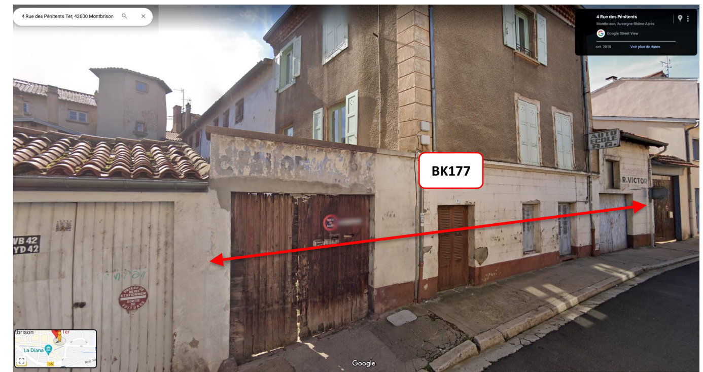
Figure 31 : Vue sur la façade sur rue des Pénitents de l'immeuble de la parcelle n°BK177
