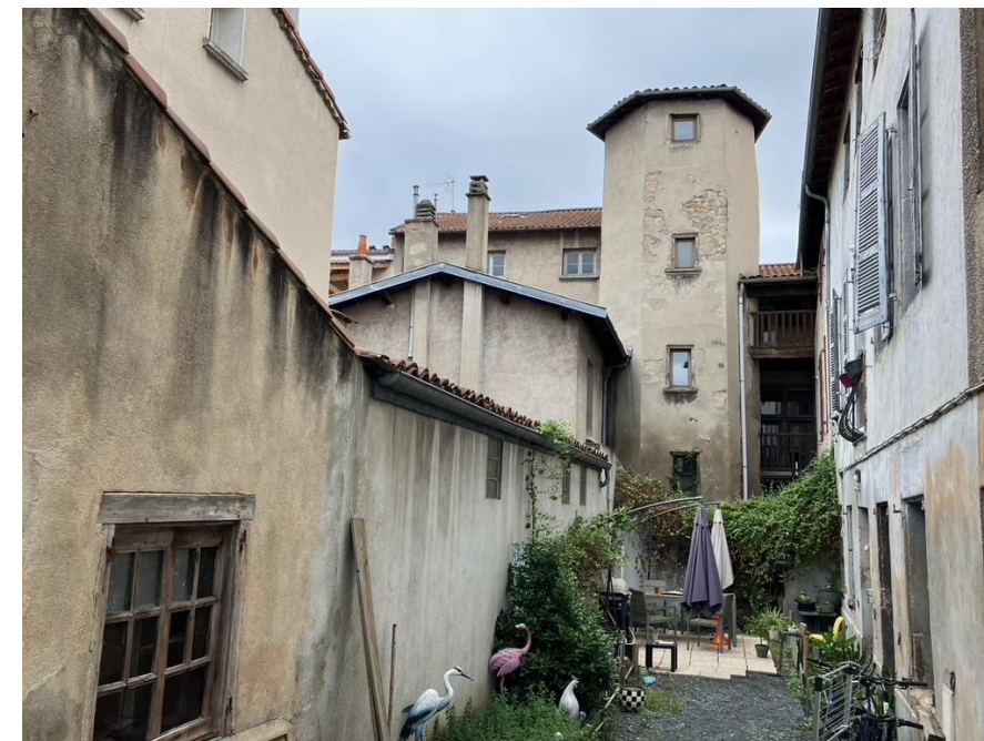
Figure 15 : Vue sur la cour intérieure du 9 rue des Pénitents (juillet 2023)
