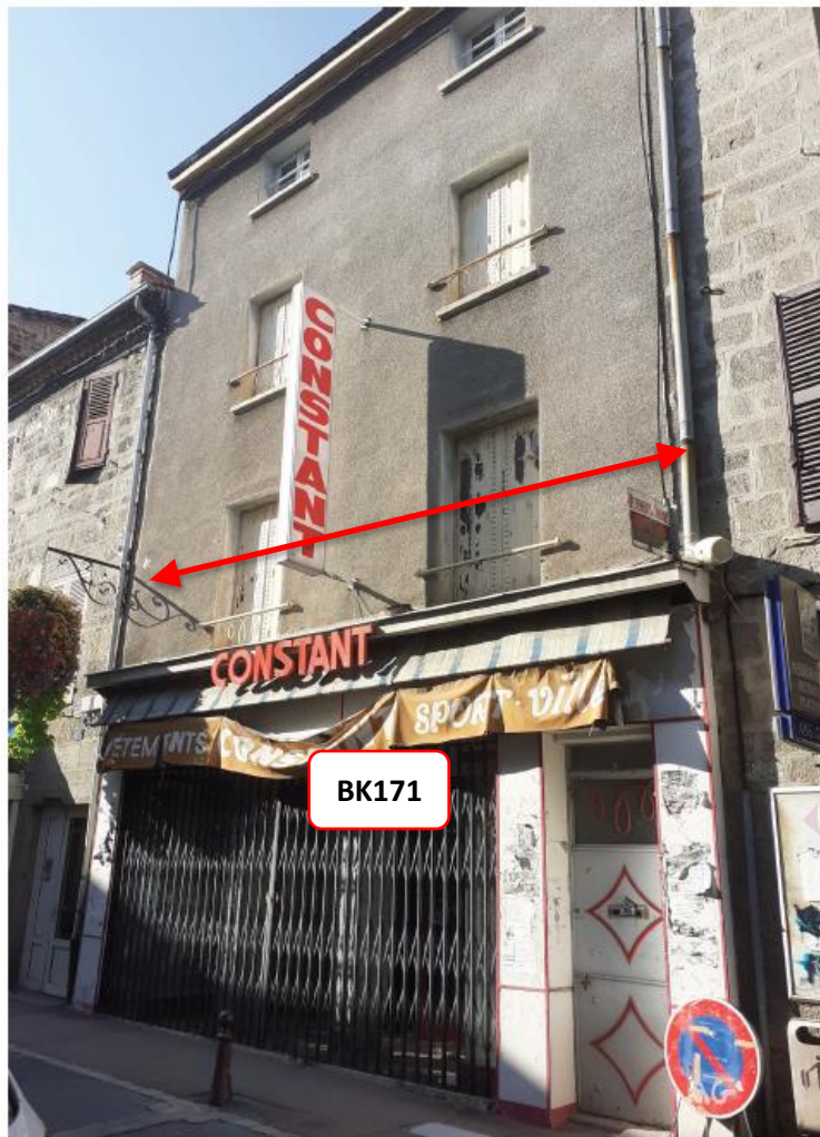
Figure 26 : Vue sur la façade sur rue Saint Jean de l'immeuble de la parcelle n°BK171
