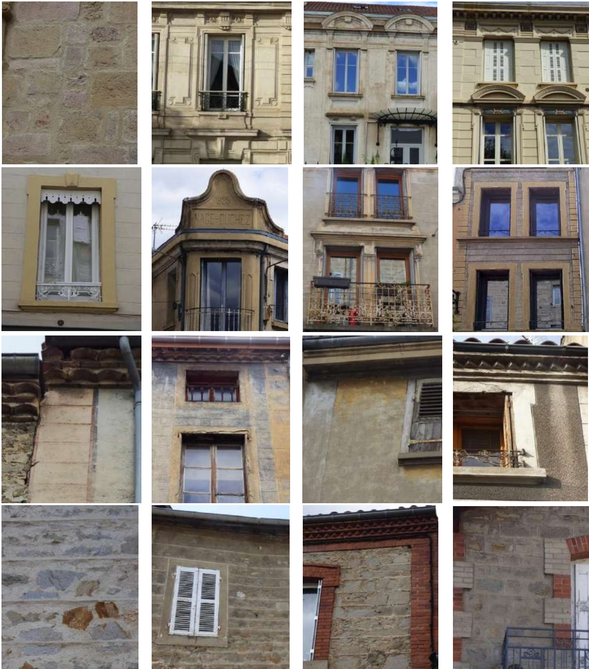
Exemples de finitions de façades : ligne 1, décors en pierre de taille; ligne 2, décors en ciment moulé ; ligne 3, façades enduites (enduit lissé à la truelle) avec décors peints (badigeons) évoquant des chaînes d'angle et des cadres de baies ; ligne 4, façades en moellons enduits à pierre vue, joints rubanés (dessinant des rubans horizontaux) et modénatures en briques ou en ciment prompt.
