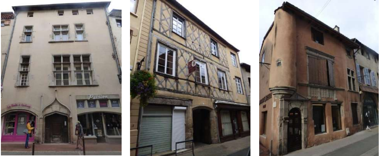
Exemples de façades de la fin du 15 e siècle (1), et du 17 e siècle en pan de bois et en maçonnerie enduite. Sur ces 3 façades les menuiseries ont été modifiées
