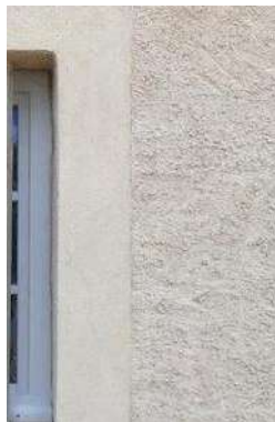
Enduit jeté recoupé à la truelle
