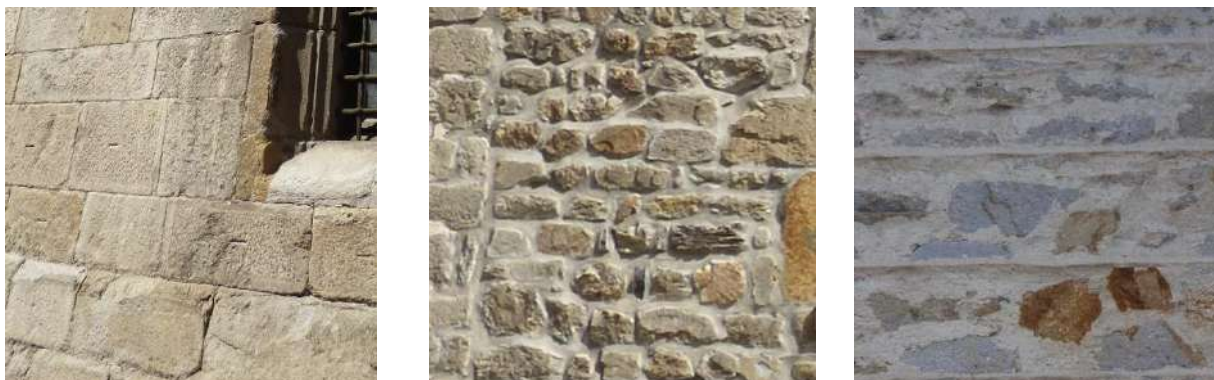
1- Façade en pierre de taille à ne pas enduire ; 2- Façade en moellons à enduire, 3- Façade à enduire à pierre vue (fin 19 e )
