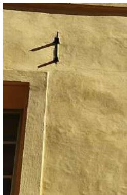
Enduit taloché lisse
