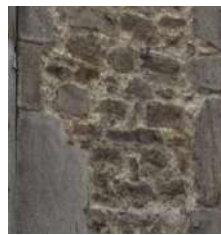
Moellons à enduire
