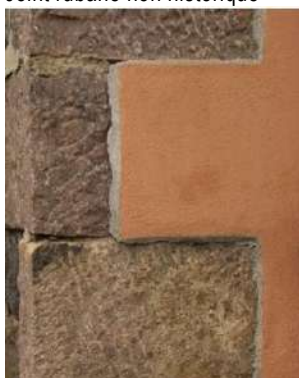
Enduit en surépaisseur sur la pierre
