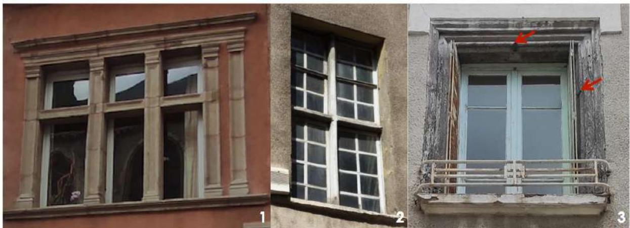
Baies à meneaux en pierre de taille (16 e -17e); 2- Baie à meneaux en bois (17e); baie avec meneaux en bois disparus (17e)
