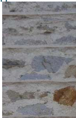
Enduit à pierre vue et joint rubanés horizontaux
