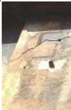
Enduit lissé badigeonné au lait de chaux
