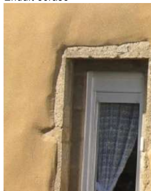
Enduit en surépaisseur avec effet matelas
