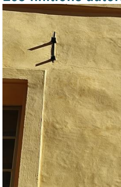
Enduit taloché lisse
