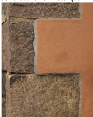
Enduit en surépaisseur sur la pierre
