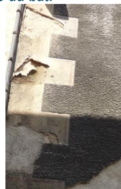
Enduit projeté fin à la tyrolienne et décors peints
