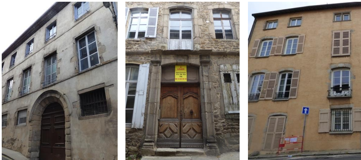
Exemples de façades du 17 e siècle et du 18 e siècle avec travées de baies superposées
