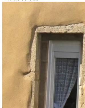
Enduit en surépaisseur avec effet matelas
