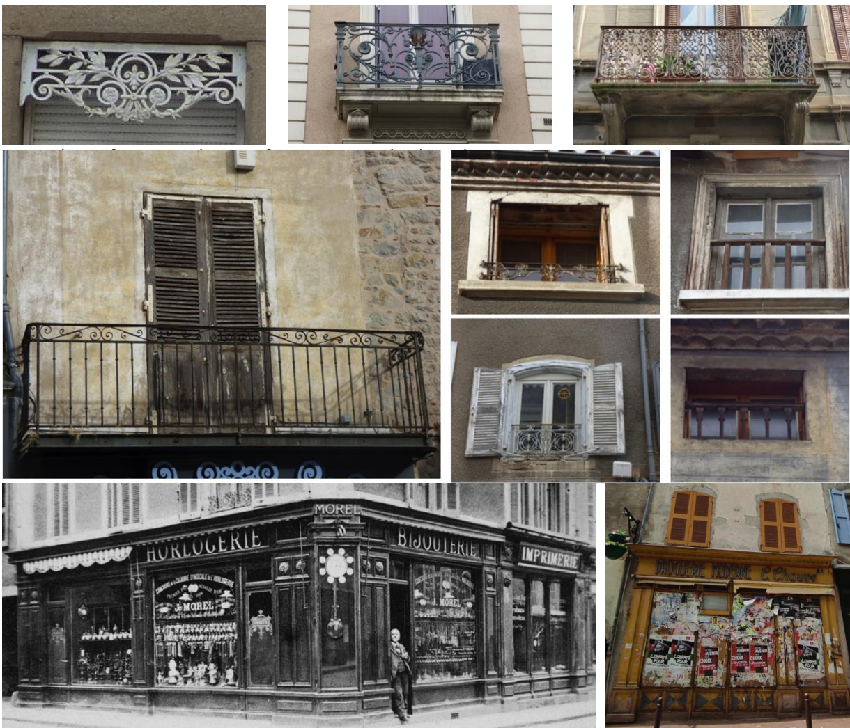
Exemples de lambrequins et de garde corps en fonte et en bois ; Décors de cadres peints ou rapportés en bois ; Devantures commerciales du 19 e s
