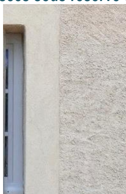
Enduit jeté recoupé à la truelle
