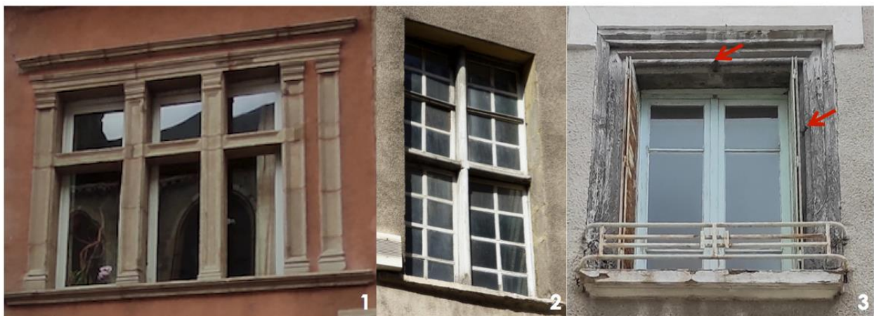
Baies à meneaux en pierre de taille (16 e -17e); 2- Baie à meneaux en bois (17e); baie avec meneaux en bois disparus (17e)
