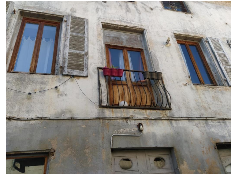
Figure 34 : Vue de la façade du lot sud de l'immeuble de la parcelle n°BK177
