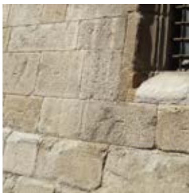
1- Façade en pierre de taille à ne pas enduire ; 2- Façade en moellons à enduire, 3- Façade à enduire à pierre vue (fin 19 e )
