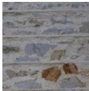
1- Façade en pierre de taille à ne pas enduire ; 2- Façade en moellons à enduire, 3- Façade à enduire à pierre vue (fin 19 e )
