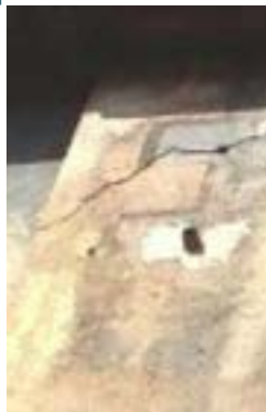
Enduit lissé badigeonné au lait de chaux
