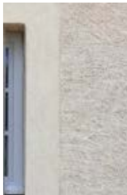
Enduit jeté recoupé à la truelle
