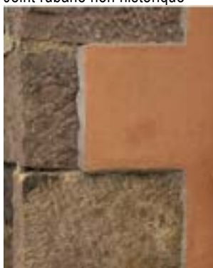
Enduit en surépaisseur sur la pierre
