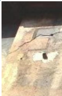
Enduit lissé badigeonné au lait de chaux
