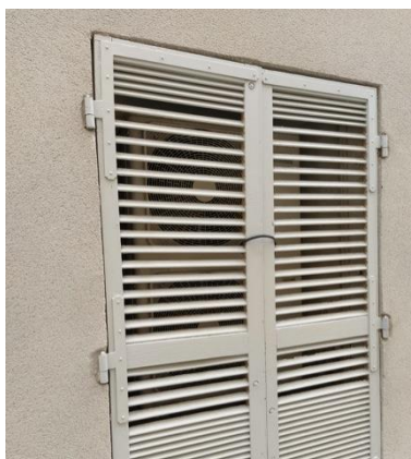
Exemples de portillon intégré dans la devanture en bois, et de volets ou de grilles ajourés masquant une climatisation
