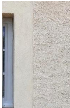
Enduit jeté recoupé à la truelle
