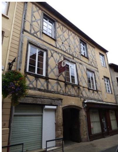
Exemples de façades de la fin du 15 e siècle (1), et du 17 e siècle en pan de bois et en maçonnerie enduite. Sur ces 3 façades les menuiseries ont été modifiées
