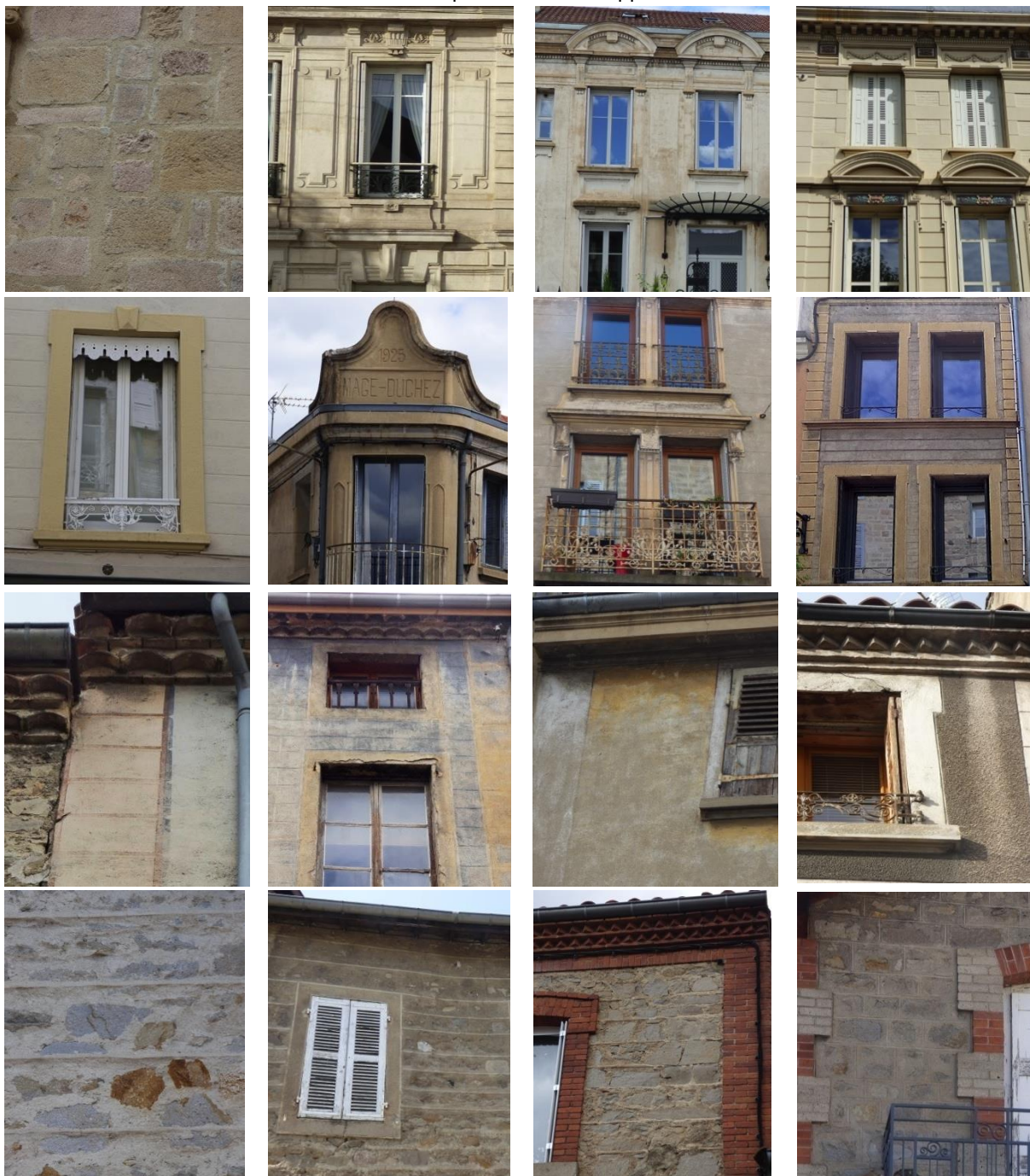
Exemples de finitions de façades : ligne 1, décors en pierre de taille; ligne 2, décors en ciment moulé ; ligne 3, façades enduites (enduit lissé à la truelle) avec décors peints (badigeons) évoquant des chaines d'angle et des cadres de baies ; ligne 4, façades en moellons enduits à pierre vue, joints rubanés (dessinant des rubans horizontaux) et modénatures en briques ou en ciment prompt.
