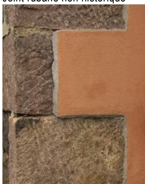
Enduit en surépaisseur sur la pierre
