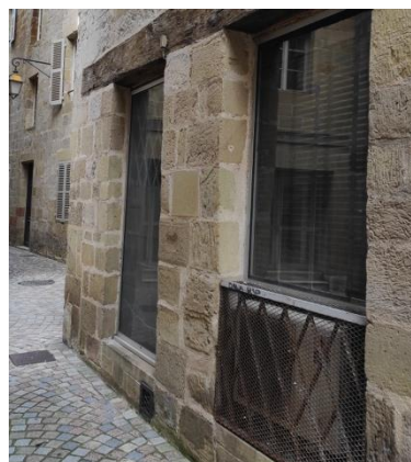
Exemples de portillon intégré dans la devanture en bois, et de volets ou de grilles ajourés masquant une climatisation
