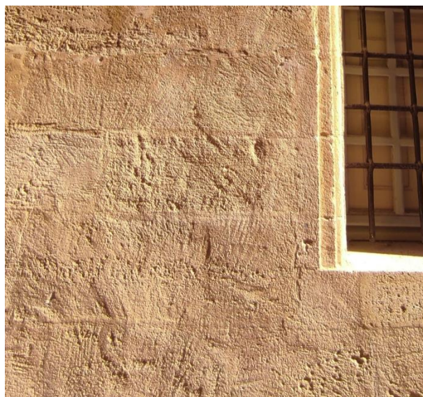
Exemples de restauration de façade en pierre de taille à Aix-en-Provence, détail sur la finition avec badigeon d'harmonisation.
