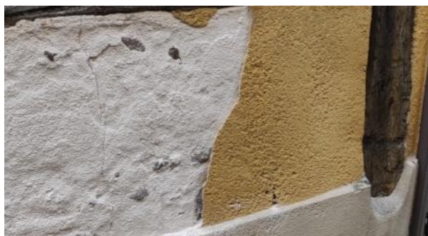
Exemples d'enduits monocouche non adhérents au support ancien ; dans le cas 2, les remontées capillaires ont provoqué la pulvérisation du support et le décollement de l'enduit
