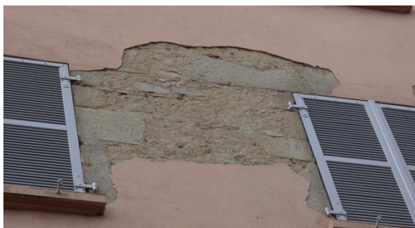
Exemples d'enduits monocouche non adhérents au support ancien ; dans le cas 2, les remontées capillaires ont provoqué la pulvérisation du support et le décollement de l'enduit
