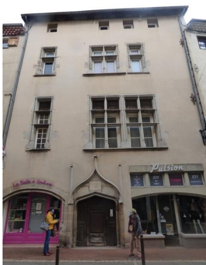
Exemples de façades de la fin du 15 e siècle (1), et du 17 e siècle en pan de bois et en maçonnerie enduite. Sur ces 3 façades les menuiseries ont été modifiées
