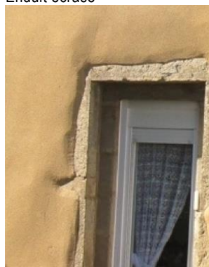
Enduit en surépaisseur avec effet matelas
