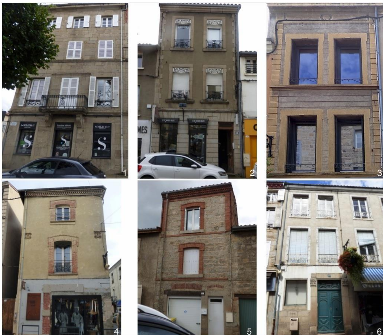
Exemples de façades caractéristiques du 19 e siècle : 1, Façade en pierre de taille ; 2, façade enduite avec décors de soubassement et chaînage en pierre ou en ciment prompt ; 3, façade enduite avec décors de faux appareil en ciment prompt et jeu de teintes à la chaux ; 4, façade enduite avec modénatures en briques apparentes ; 5, façade à pierre vue et joints rubannés avec modénatures en briques apparentes ; 6, facade enduite avec modénatures peintes. Voir fiche conseil correspondante pour comprendre les différents finitions et mises en oeuvre.
